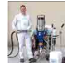
Anfahren des Spritzvorgangs
